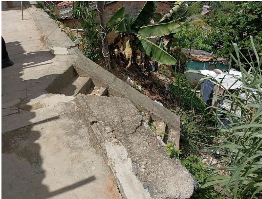
Figura 5.3.- Vista da parte da escadaria danificada, na porção superior do talude, como ilustrado na figura anterior.
