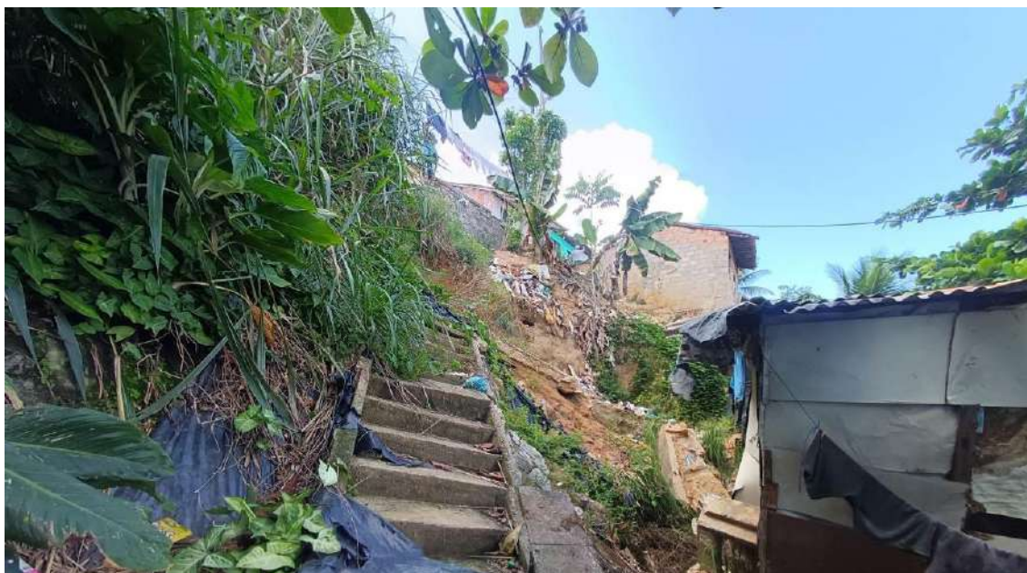
Figura 5.4.- Foto tirada a jusante do talude, nota-se a escadaria danificada, atingindo uma edificação situada no pé do talude. Observa-se lixo e entulho acumulado na meia encosta.
