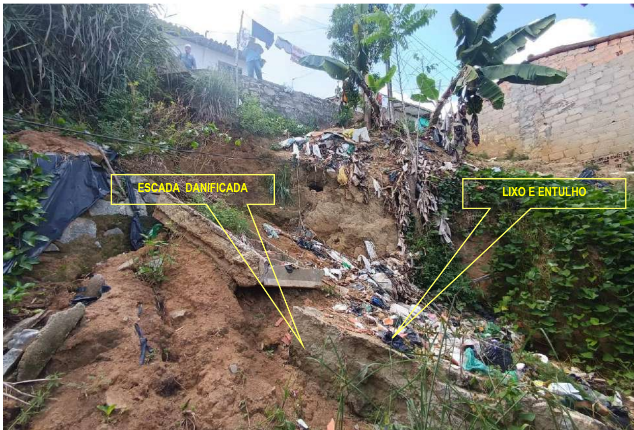
Figura 5.5 Foto da meia encosta, nota-se o grande acúmulo de lixo e entulho presente no talude e drenagem danificada.
