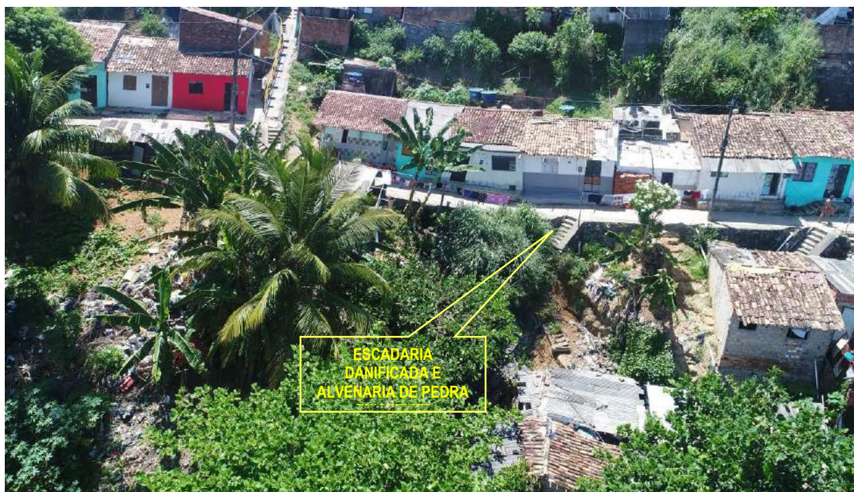
Figura 5.2.- Vista aérea frontal do talude, observa-se a presença de vegetação de grande porte, alvenaria de pedra existente a n crista do talude..
